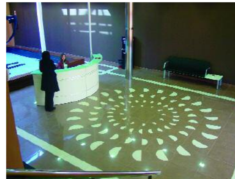
Corte realizado sobre porcelánico mediante tecnología waterjet.
